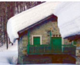
C7-02 Neve su tetto
